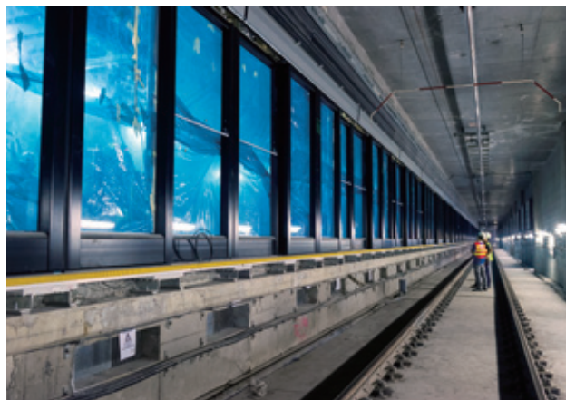
新鐵路綫工程包括大規模的隧道挖掘
