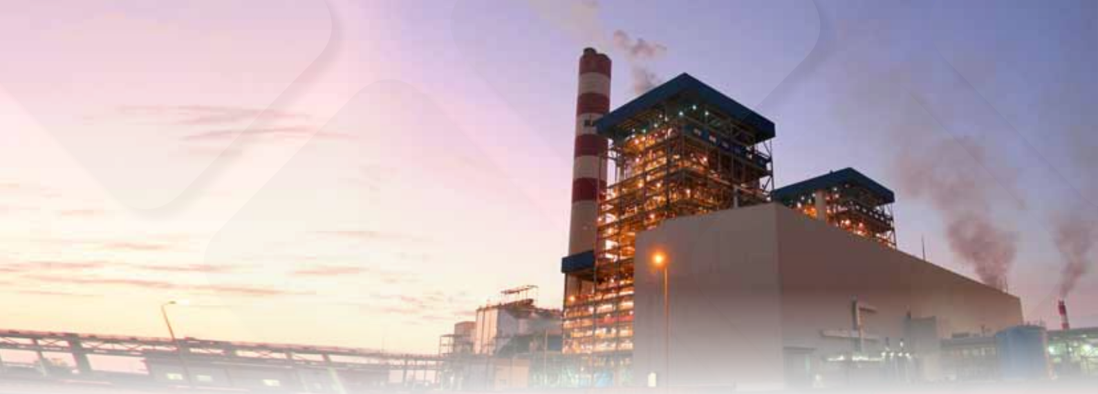
東方電氣沙特拉比格2×660MW燃油電站工程
