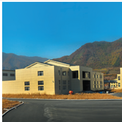
通天酒窖及 通天酒莊的建築工程 已於本年度竣工。
