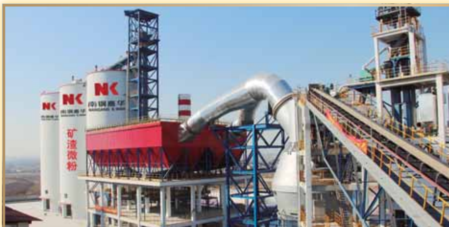
南京南鋼嘉華新型建材有限公司之第二期礦渣微粉廠
