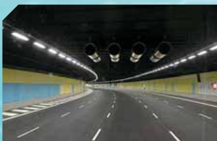
新加坡 濱海高速公路 (MCE) 隧道覆蓋項目
