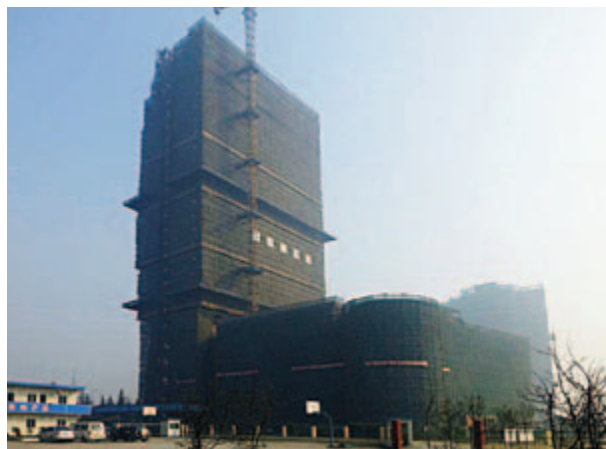
■ 綜合發展項目第一期酒店之結構建造工程已竣工
