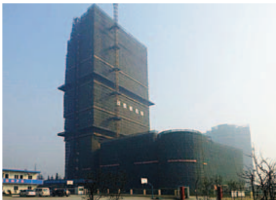
■ 綜合發展項目第一期之酒店之結構建造工程經已完成
