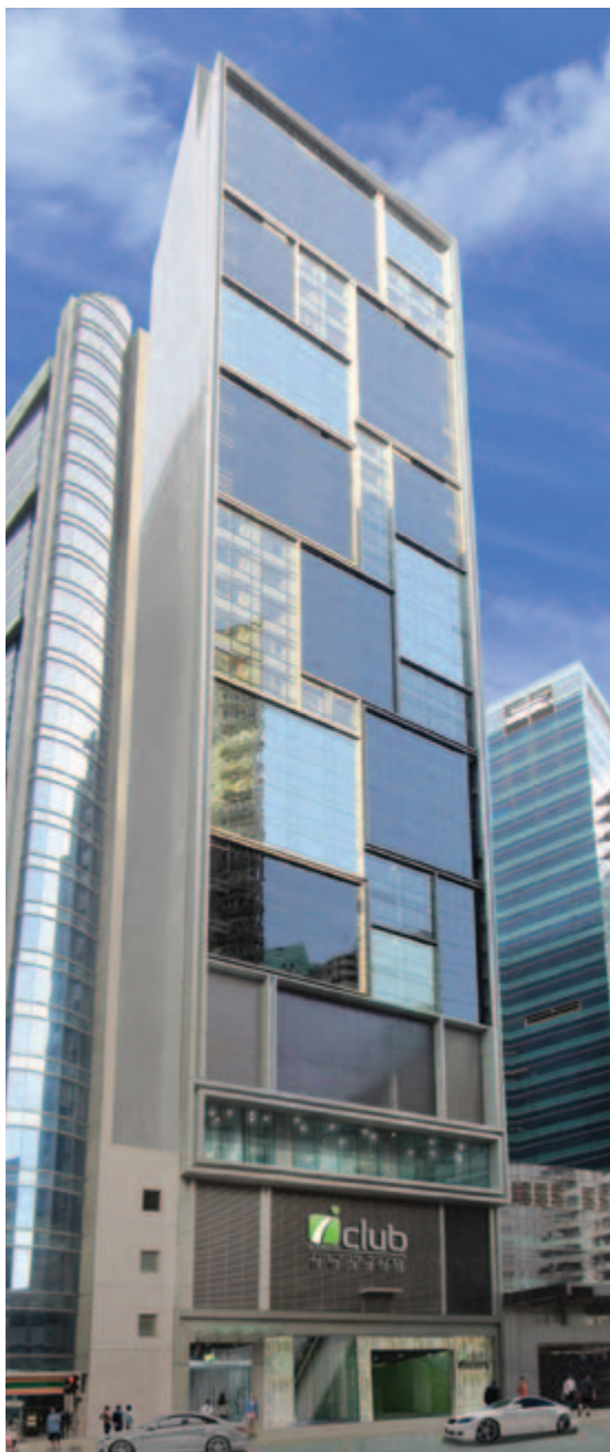
■ 位於北角麥連街 14 至 20 號之新酒店發展項目接近竣工
