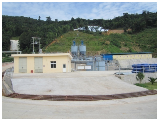
紫金山金铜矿余田坑废水处理系统
