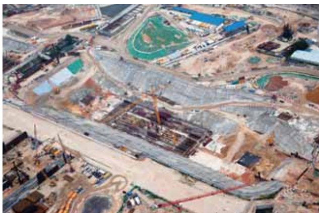
沙中綫：啟德站及相關隧道之土木工程
