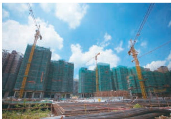
寶翠園三期一上蓋建築工程正在進行中
