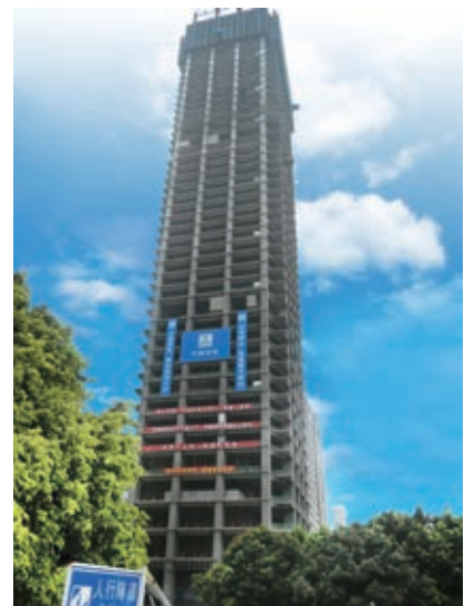
漢國城市商業中心—上蓋建築工程正在進行中
