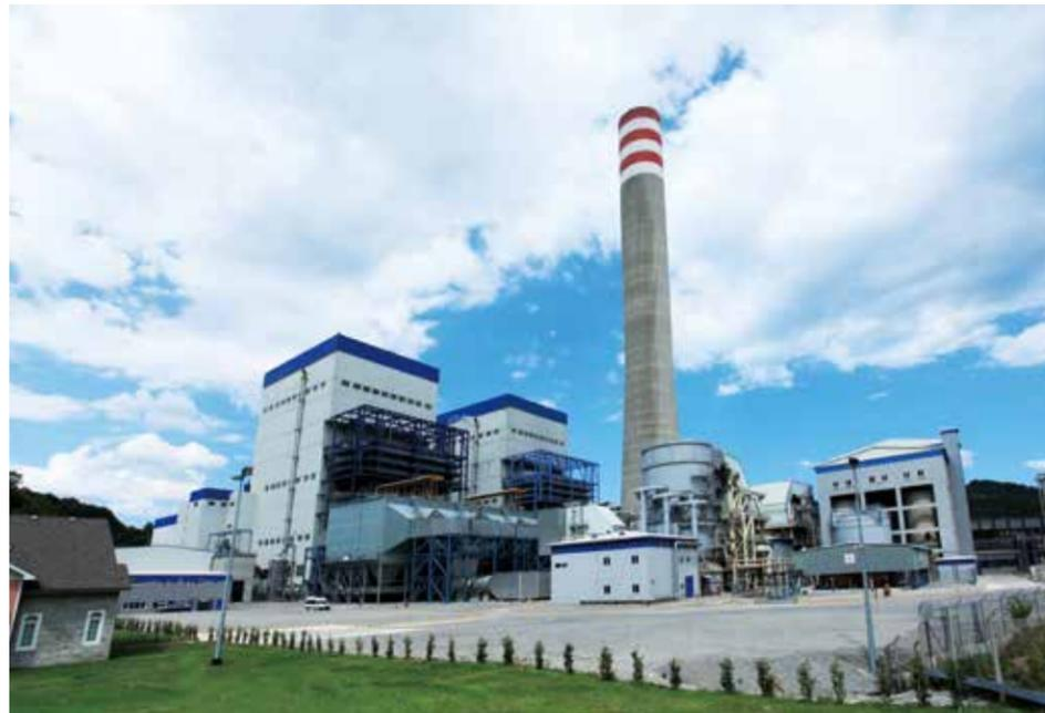
土耳其 EREN (1+1) ×60 万千瓦超临界燃煤电站项目锅炉后部脱硫脱硝设备全景
