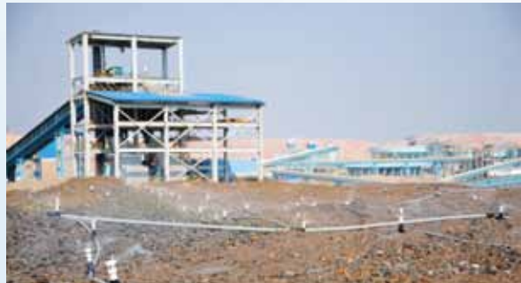
穆利亞希堆浸系統1號堆場噴淋作業
