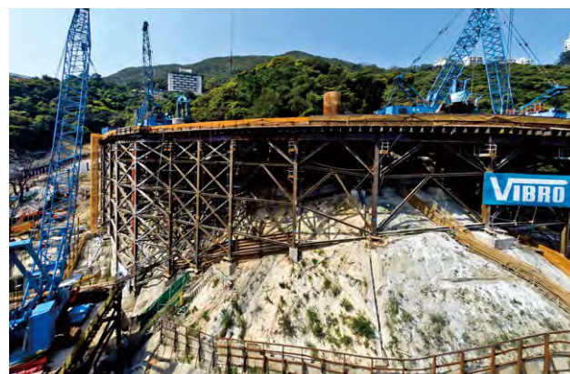
惠保(香港)有限公司進行打樁及地盤平整工程
