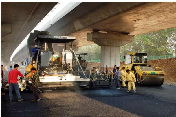
中，就地熱再生總處理面積約為 12.6 萬平方米，可節約瀝青混合料約 12,600 噸，相當於減少了約 0.5 萬立方米礦產資源的開採量，避免了約 2,400 平方米自然環境的破壞，減少的運輸量相當於減少碳排放約 47 噸。
