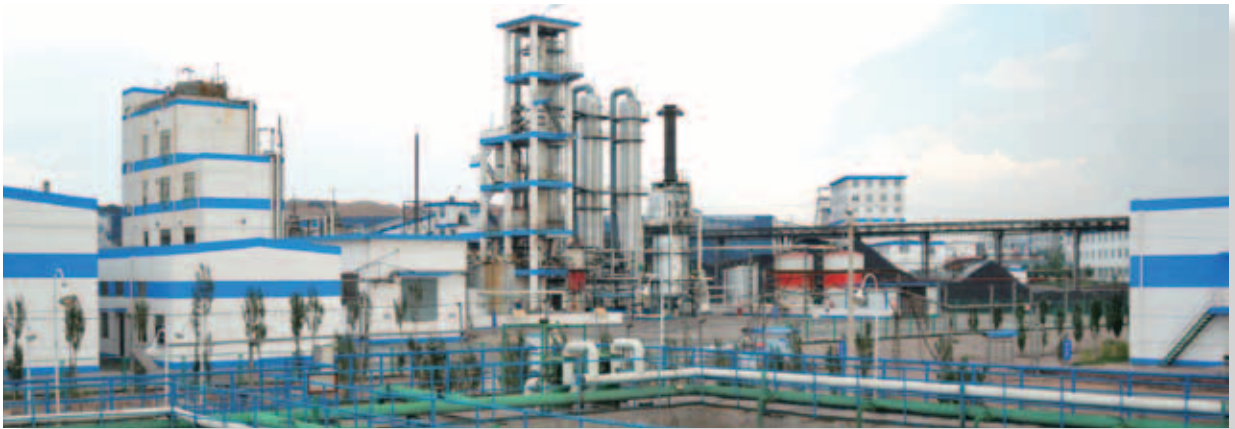
包頭煤化工污水處理系統
