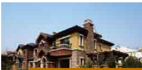
長河玉墅二期紅橡墅樣板樓
