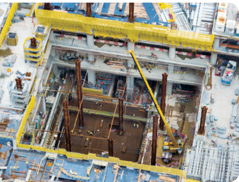
截至2014年年底，西九龍總站的整體挖掘工程已完成88%
