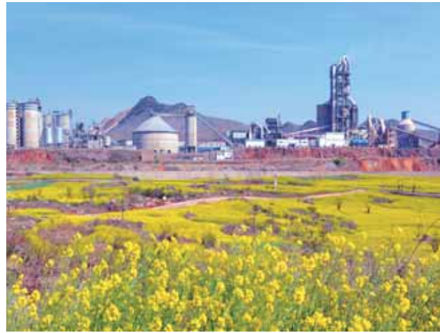
曲靖昆鋼嘉華水泥建材有限公司水泥生產廠房
