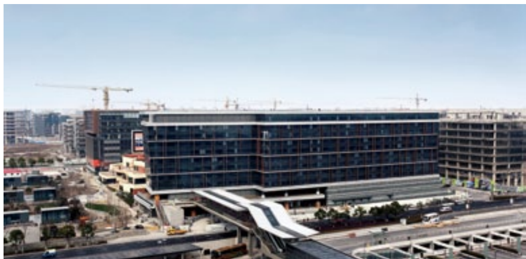
在建中的虹橋天地
