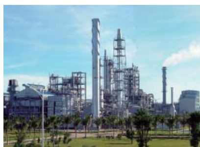
海南生產裝置
