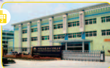
位於浙江桐鄉的油墨廠房 The inks plant in Tunxiang, Zhejiang
