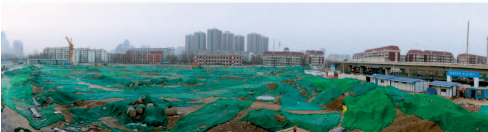
■ 位於天津之綜合發展項目一打樁工程經已完成
