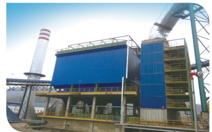
华润水泥(金沙)有限公司窑头袋式除尘器
