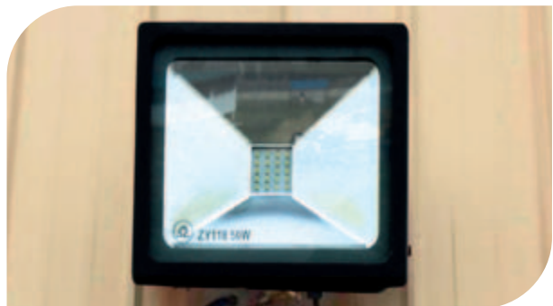
改造後的60瓦LED節能射燈
