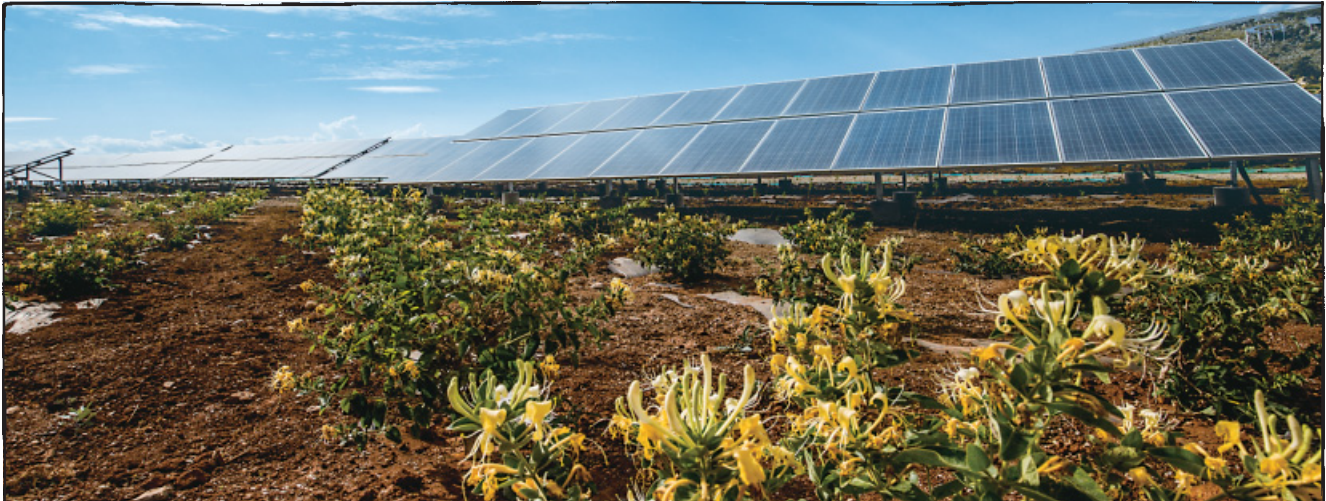
西村一期光伏電站是中電在中國內地的首個全資太陽能光伏發電項目，也是雲南省首個大型「農光互補」示範項目
