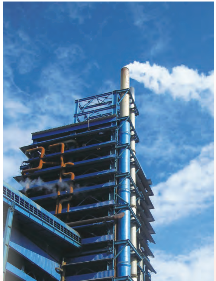
銅冶煉公司ISA爐廠房
