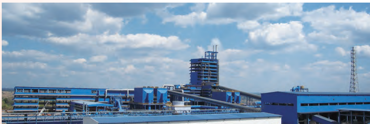
銅冶煉公司廠房全景
