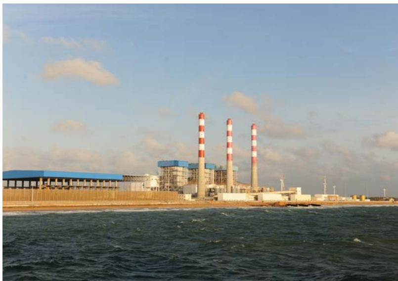
▲ 斯里兰卡普特拉姆3x300MW燃煤电站项目
