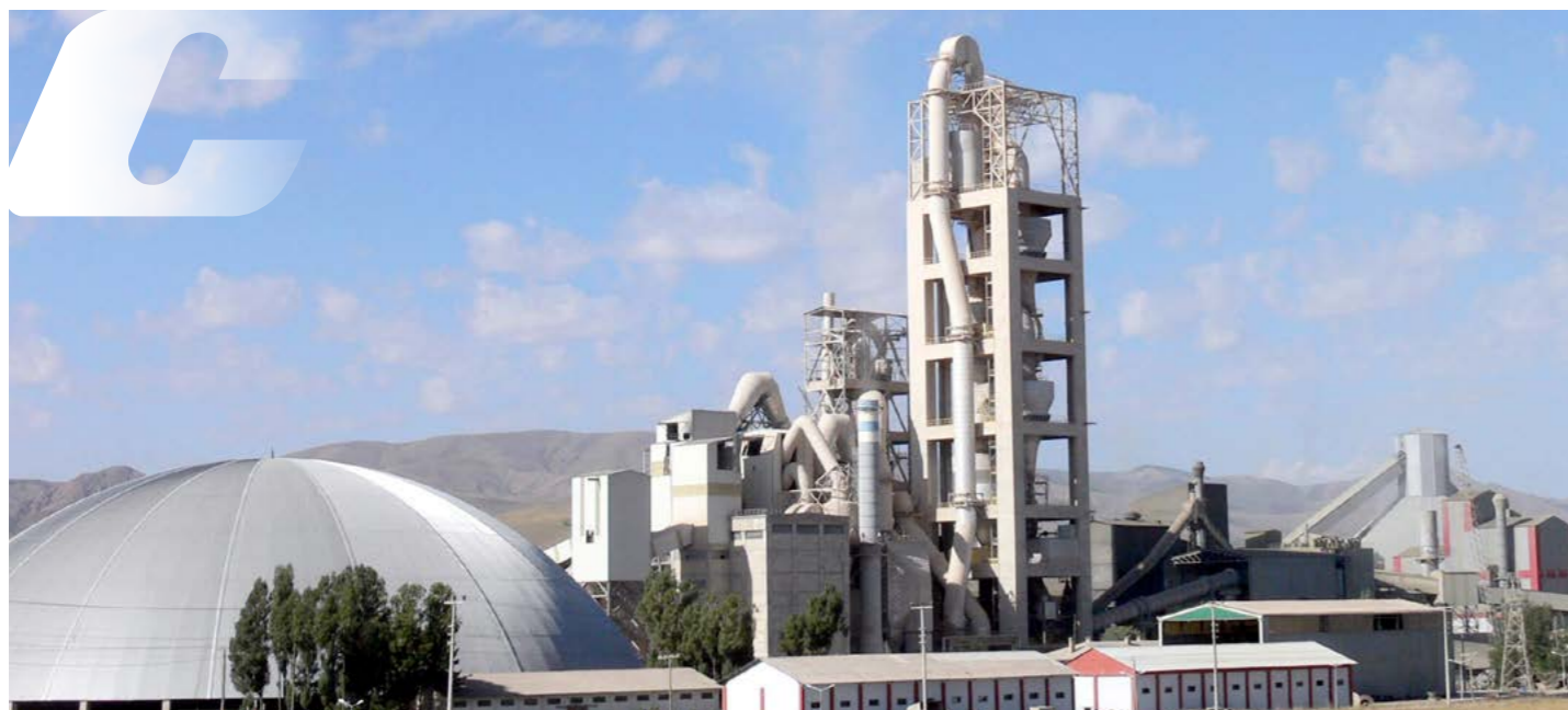
▲ 土耳其ASKALE 3400吨/天水泥厂车间项目
