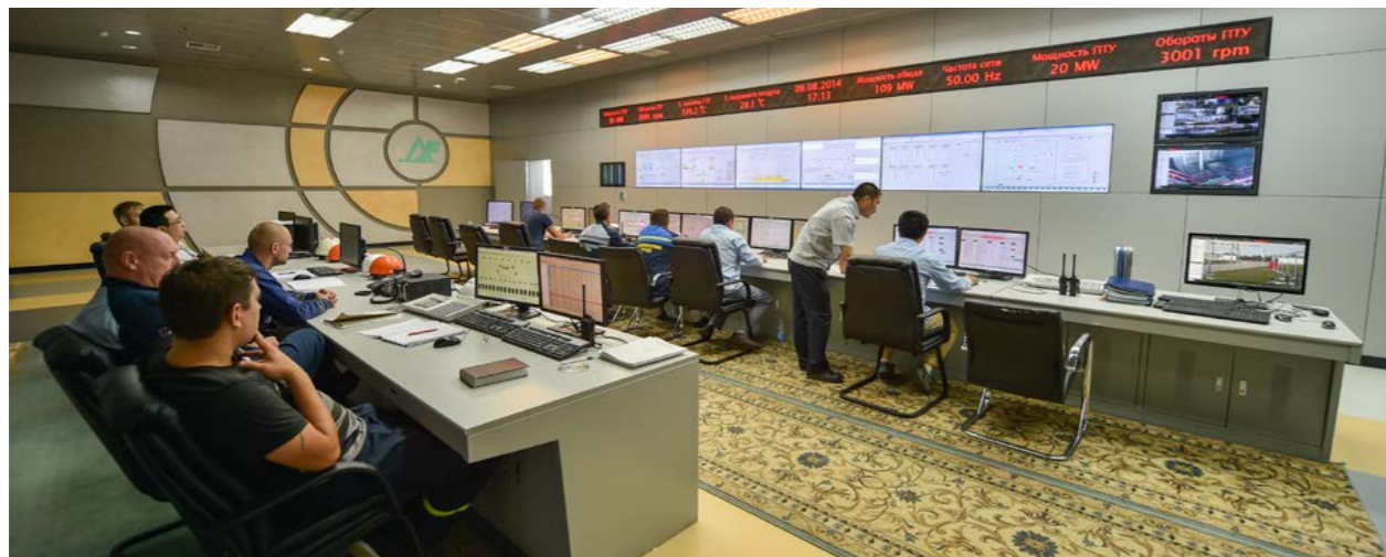
▲ 卢克木里400MW联合循环电站安全生产控制室
