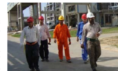
▲ 安全生产管理人员在现场巡查
