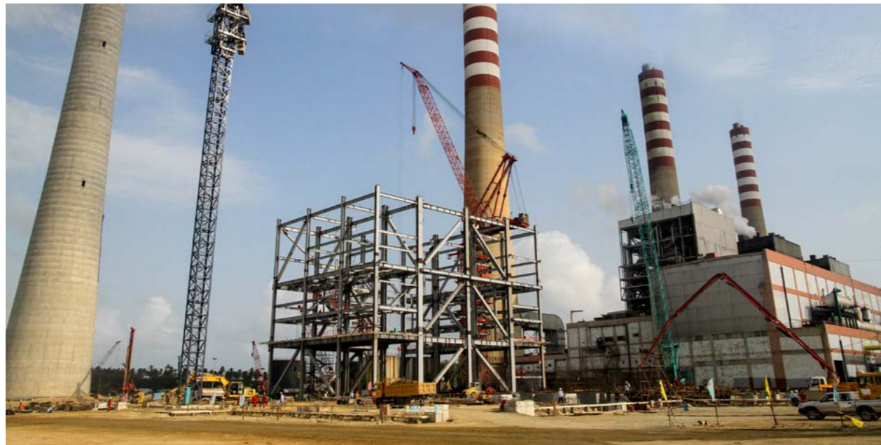
▲ 委内瑞拉中央电厂6号600MW蒸汽轮机发电机组项目
