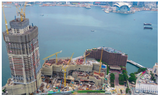
新世界建築有限公司承建尖沙咀新世界中心重建項目
