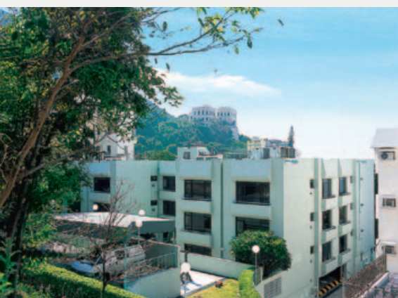
Fairview Court 富慧閣
