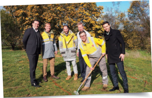
CitiPower 及 Powercor 透過電池儲能計劃，投資未來的電網項目。
