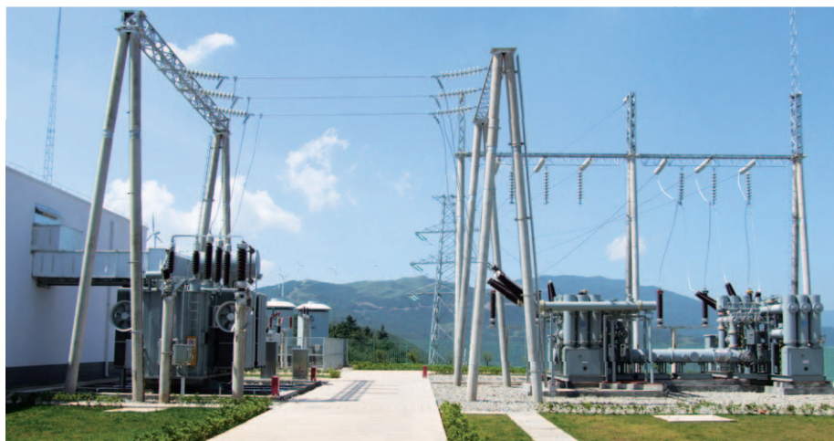
大理發電廠進行改善工程，提高生產力水平。
