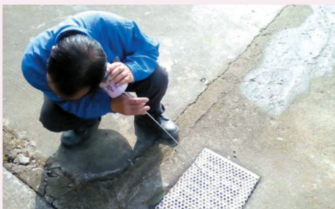
使用檢漏儀查找看不見的滲漏位置
