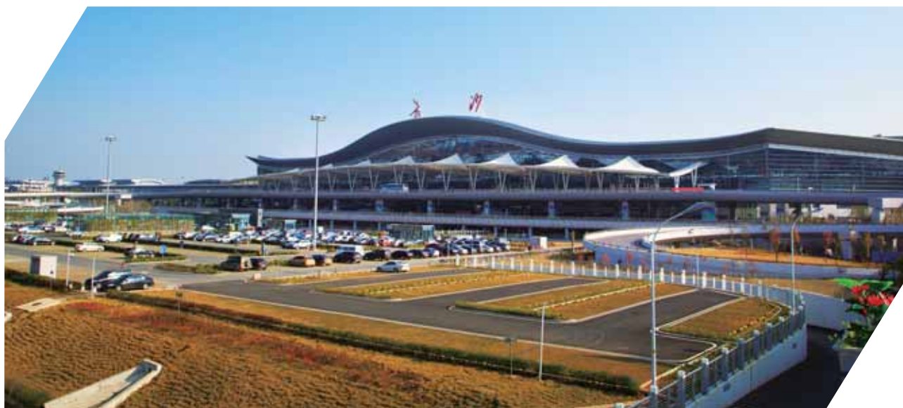
公司承建的黃花機場冷熱電三聯供能源站工程
