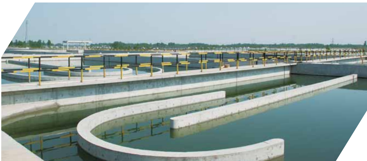
公司承建的河南省最大的污水處理廠
