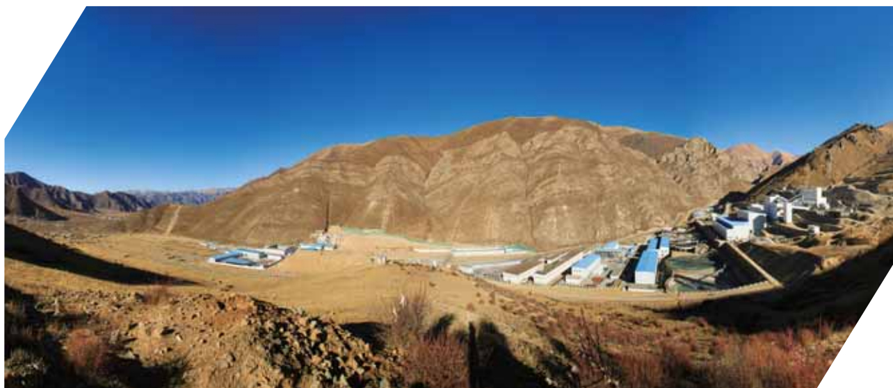
公司承建的西藏甲瑪銅多金屬礦一期採選工程
