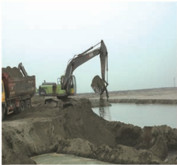
對尾礦砂進行水泥混合料的綜合利用 1 (楊莊鐵礦)
