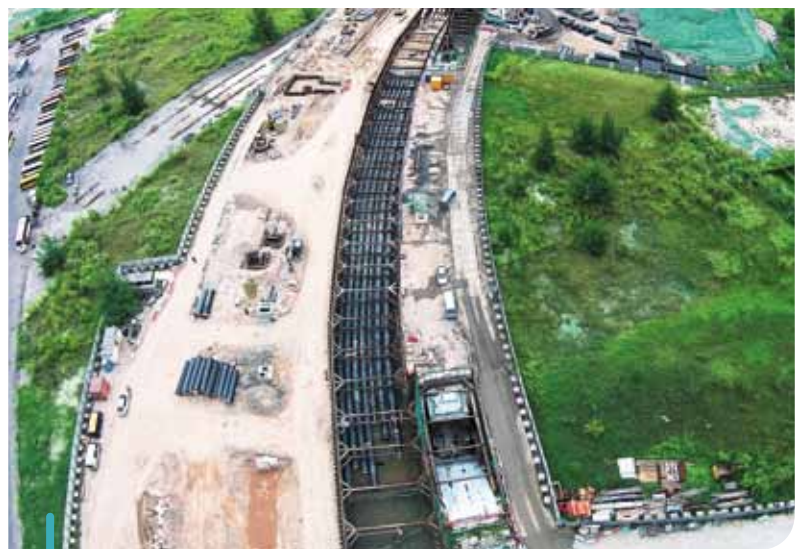
卓裕於啟德發展區之地下海水冷卻系統工程項目進展順利。
