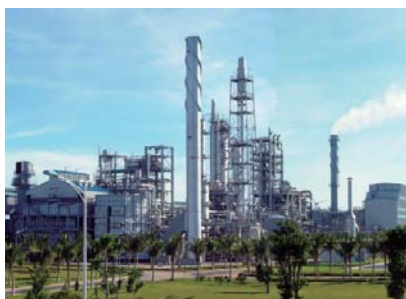
海南生產裝置
