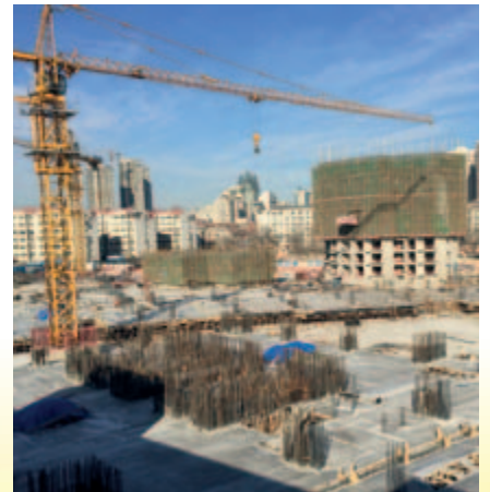
■ 綜合發展項目住宅大樓 — 上蓋工程進行中
