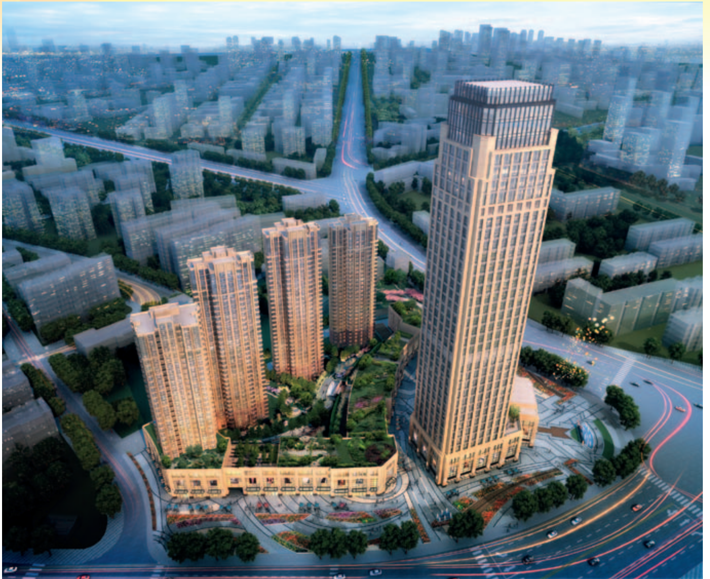
■ 位於天津河東區黃金地段之商業/寫字樓/住宅綜合發展項目(*)
