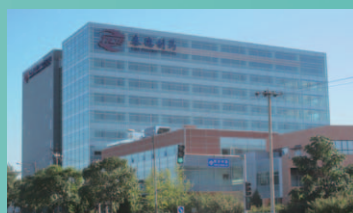
北京泰德廠房
