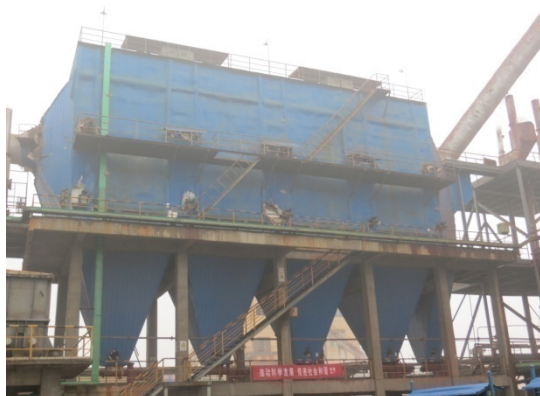
洛宁紫金黄金冶炼公司除尘器
