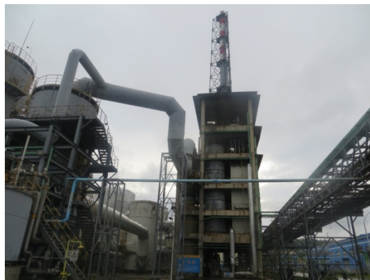
紫金铜业硫酸尾气脱硫设施
