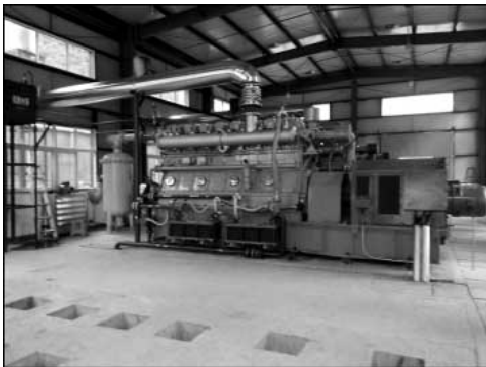
圖22-1：威奢發電站配備500kW內燃機的發電機組
