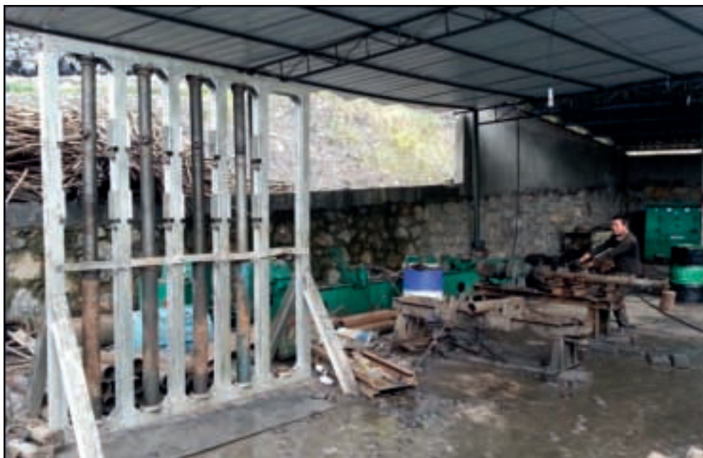
圖13-5：對拉蘇液壓支柱的維護作業及測試
