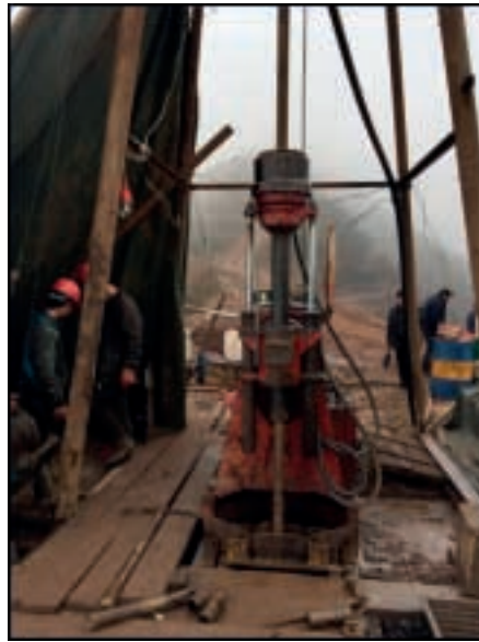
圖9-1：二零一四年鑽探計劃鑽機
