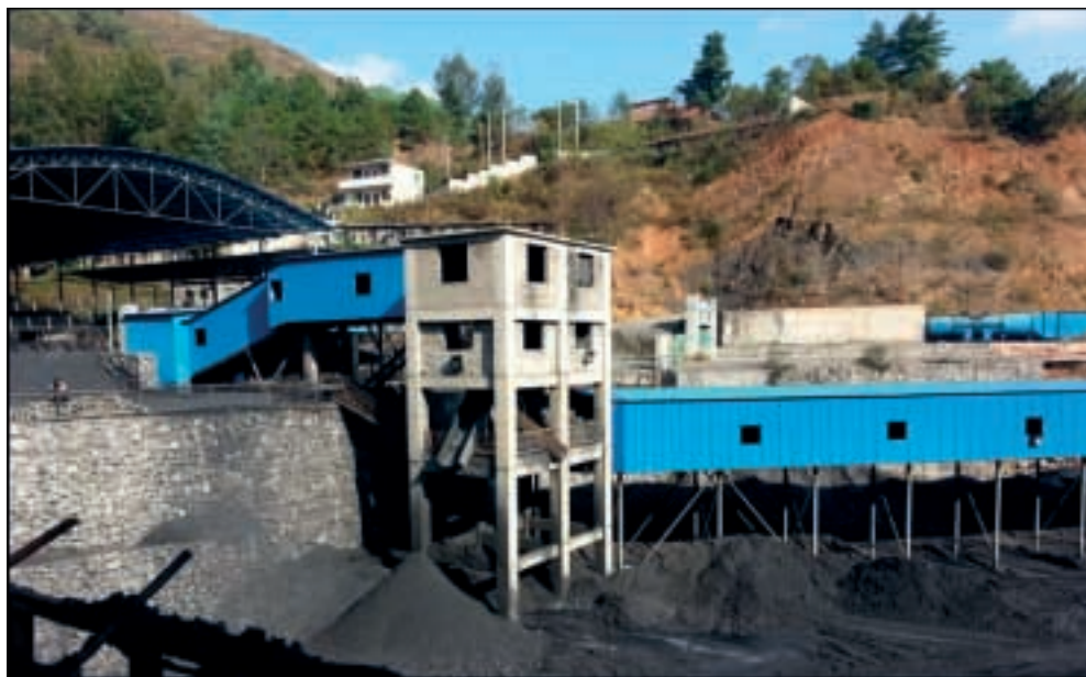
圖13-6：具有帶蓋礦區、篩分車間、回氣斜井和排氣扇的羅州煤礦
