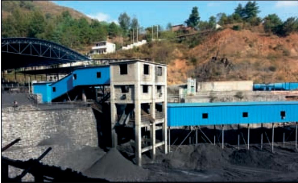
圖13-6：具有帶蓋礦區、篩分車間、回氣斜井和排氣扇的羅州煤礦
