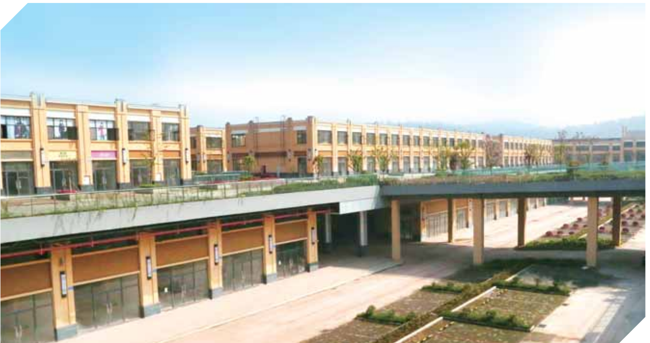
Detached style trade center in CSC Chongqing 於重慶華南城的單幢式商品交易中心
