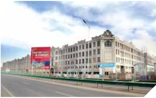
Trade center under construction in CSC Harbin 於哈爾濱華南城的在建商品交易中心
