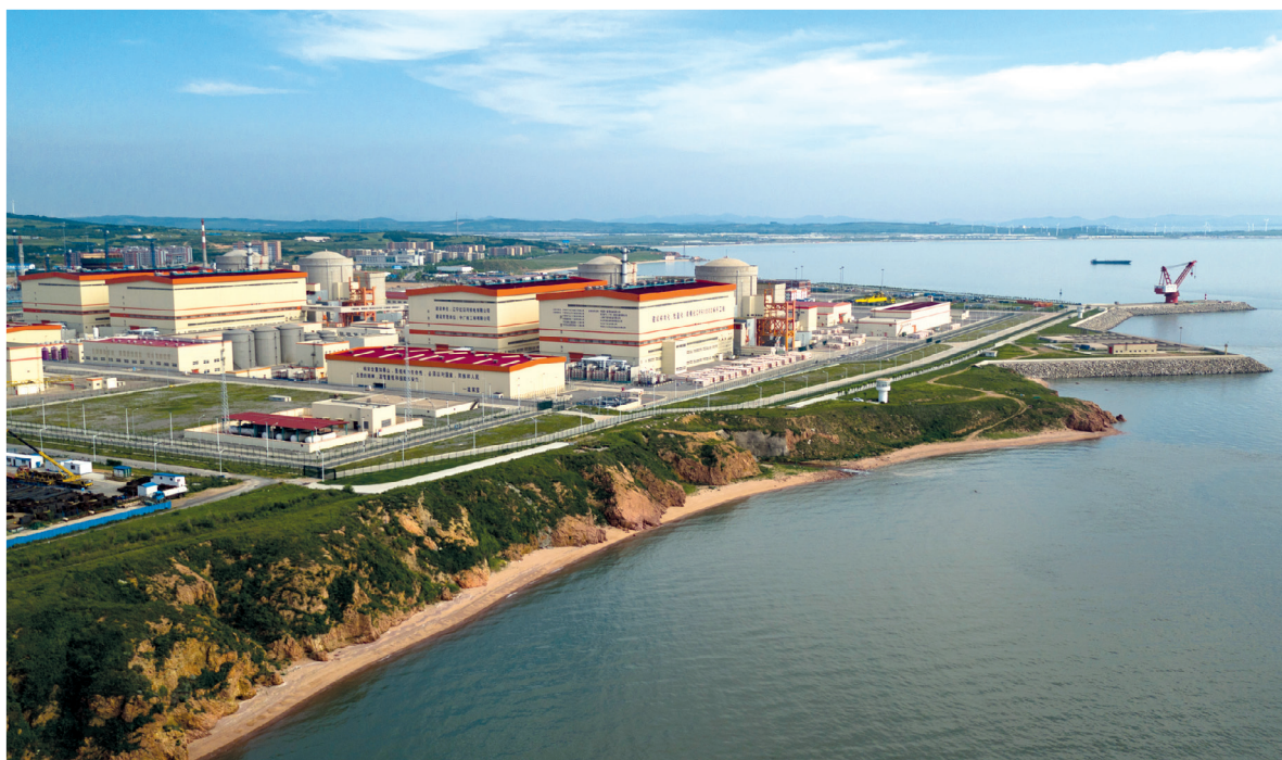
建設中的紅沿河核電站
