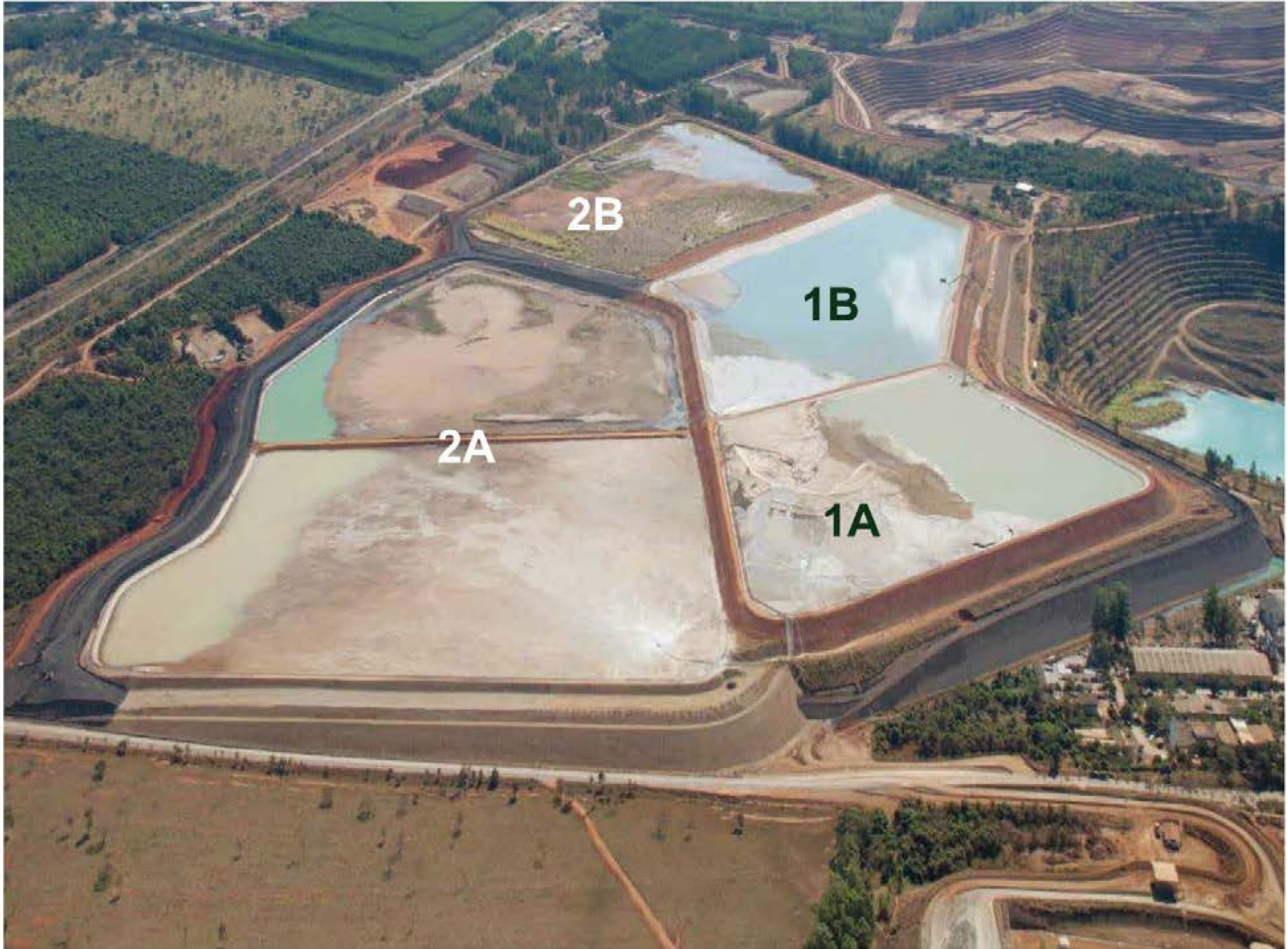
图 0-2 铌尾矿储存设施全景图
