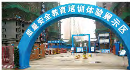
合肥橡树湾项目安全体验区建设
