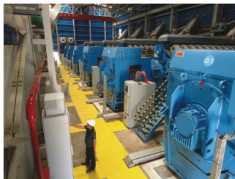
中速發動機式燃氣分佈式發電站
