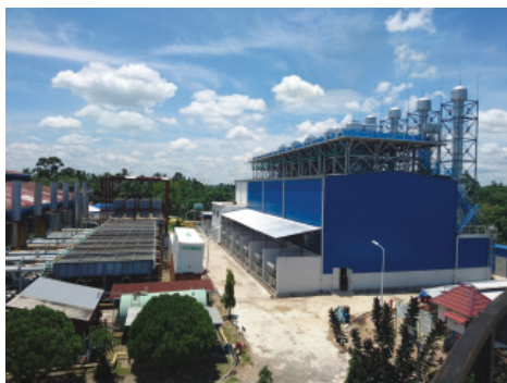
中速發動機式燃氣分佈式發電站
