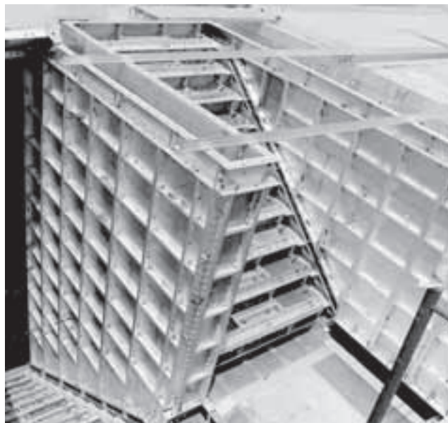
牆體及樓梯鋁合金板模
