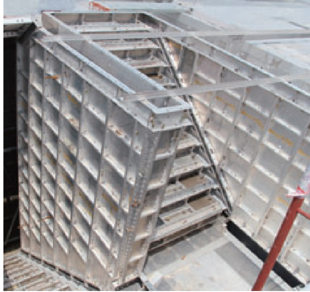
牆體及樓梯鋁合金板模
