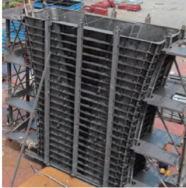
橋柱鋼化板模
