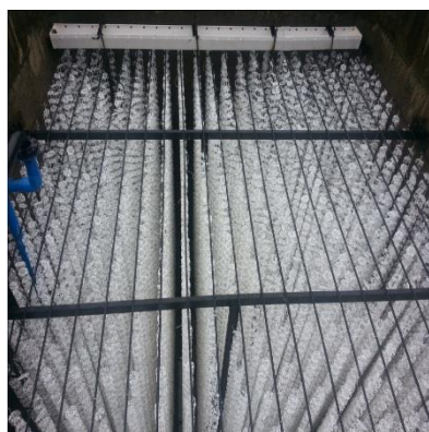
圖注：廣州漢方改造污水處理站
